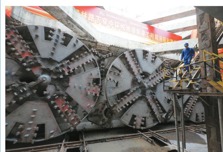
三台大型盾构机顺利穿越中环线。
