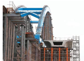
新春佳节即将来临,京雄城际铁路传来好消息。由中铁十二局集团一公司负责施工的京雄城际铁路最长桥梁工程——黄国特大桥双线简支钢拱顶推施工3日上午顺利完成。
