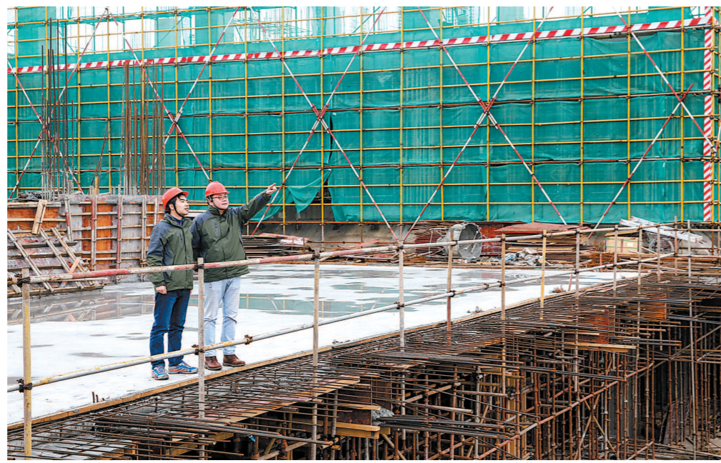
昨天,在启迪漕河泾(中山)科技园项目三期建设现场,施工方在巡查工地。
