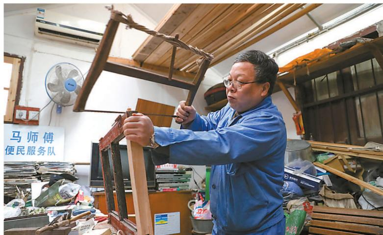
马师傅将破损的木窗拆回工作室进行修复。
