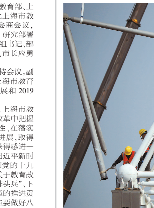
特斯拉工厂吊装屋顶网架 建设者在吊装钢结构屋顶网架。当日,位于临港的特斯拉超级工厂项目(一期)两组钢结构屋顶网架吊装顺利完成。钢结构主要由95根矩形框架柱和钢网架屋面组成,网架采用螺栓球+焊接节点的正方四角锥形。 本报记者 张海峰 摄
