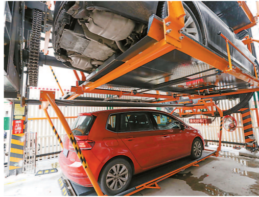
立体停车库采用模块化组合机架,通过机械装置上的链条循环实现车位上下和左右移动。
