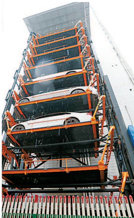
位于莘浜路近莘东路口的无人值守停车“神器”共有10层。
