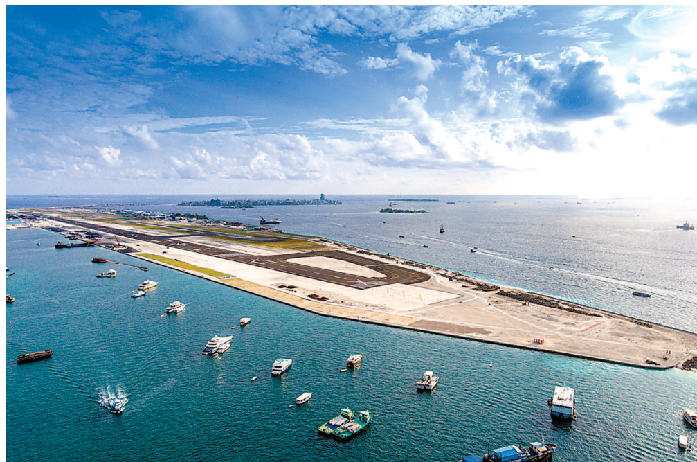
由中国企业承建的马尔代夫维拉纳国际机场新跑道。
