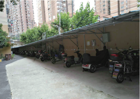
智能车库改造前
