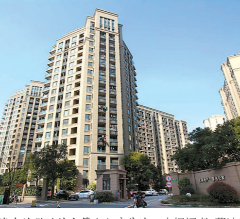
铁路上海南站附近的市筹公租房基地。本报记者 蒋迪雯 摄
