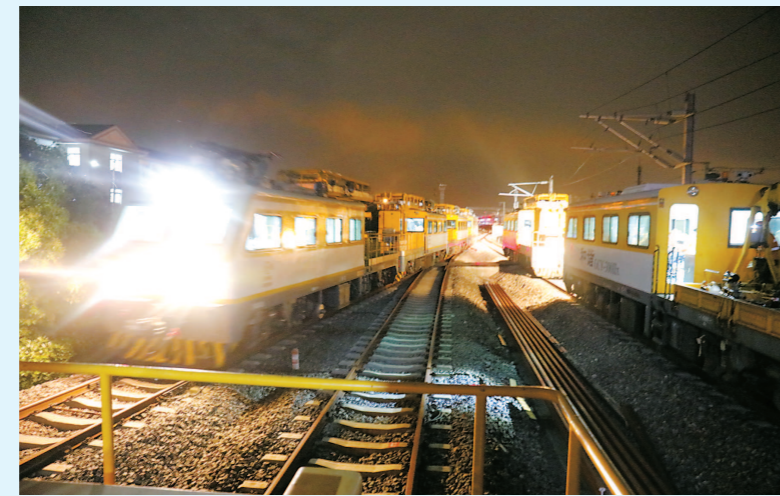
昨天凌晨,四列连接在一起的轨道车从金山北综合维修工区开出。
