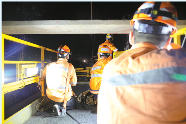
轨道车移动时,集中修队员需要蹲下,防止被电线打到。
