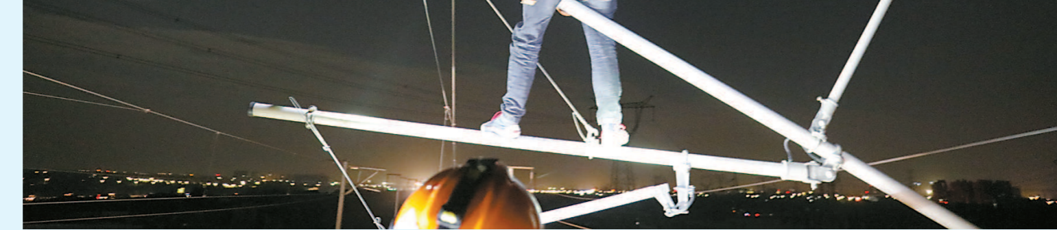
供电专业工作需要在地面6米的高空进行,主要检查给高铁供电的接触网以及线、杆接触部分的零件情况。
