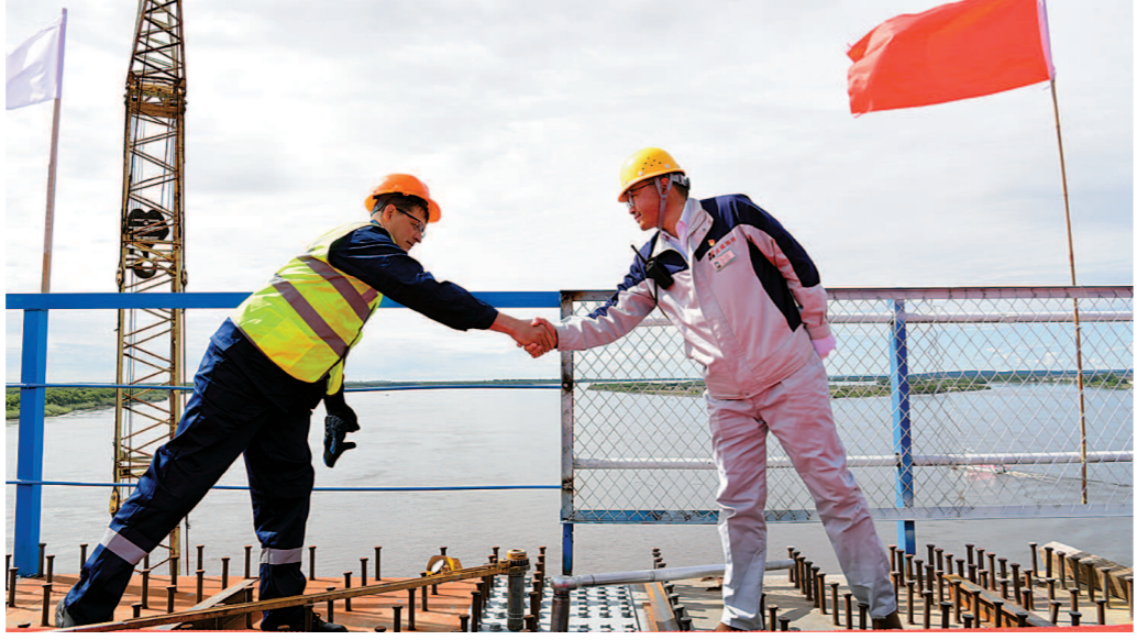
5月31日,中俄双方建设者合力将螺栓安装到合龙块上后握手。当日,中俄黑河—布拉戈维申斯克界河公路大桥合龙。
