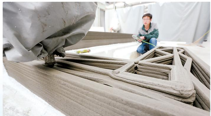
位于江苏昆山的一家高科技企业利用建筑垃圾制成的特殊“油墨”,依据电脑设计的图纸和方案,经一台大型3D打印机层层叠加喷绘建筑墙体。
