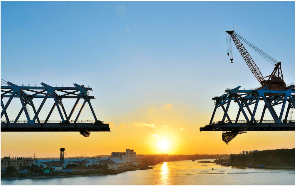
徐宿淮盐铁路连接江苏徐州、宿迁、淮安、盐城4市，线路全长约300公里，全程设计行车速度为250公里/小时，是江苏腹地重要的铁路大动脉之一，被誉为江苏铁路的“金腰带”。目前，徐宿淮盐铁路正加紧施工，预计2019年底达到通车条件。
