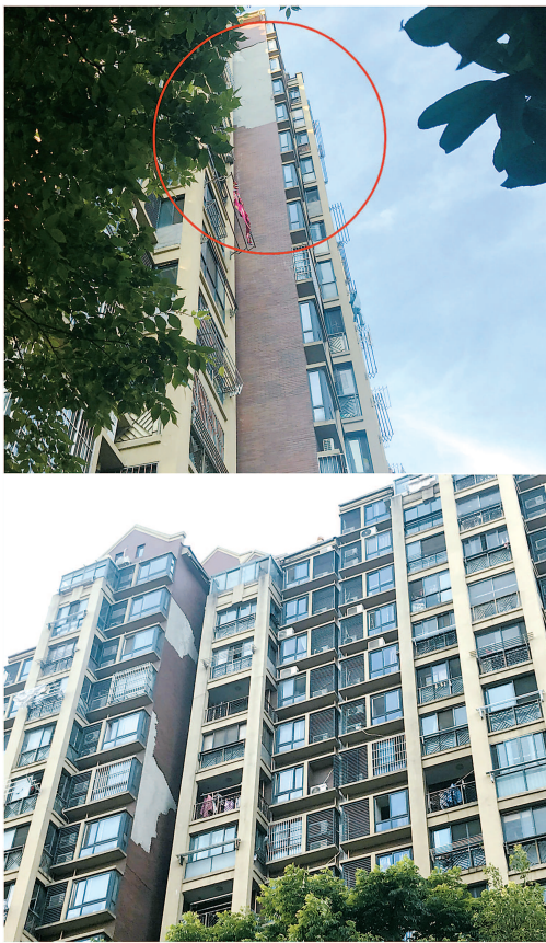
小区多栋楼外立面墙砖脱落,露出灰色墙体。车佳楠 摄
