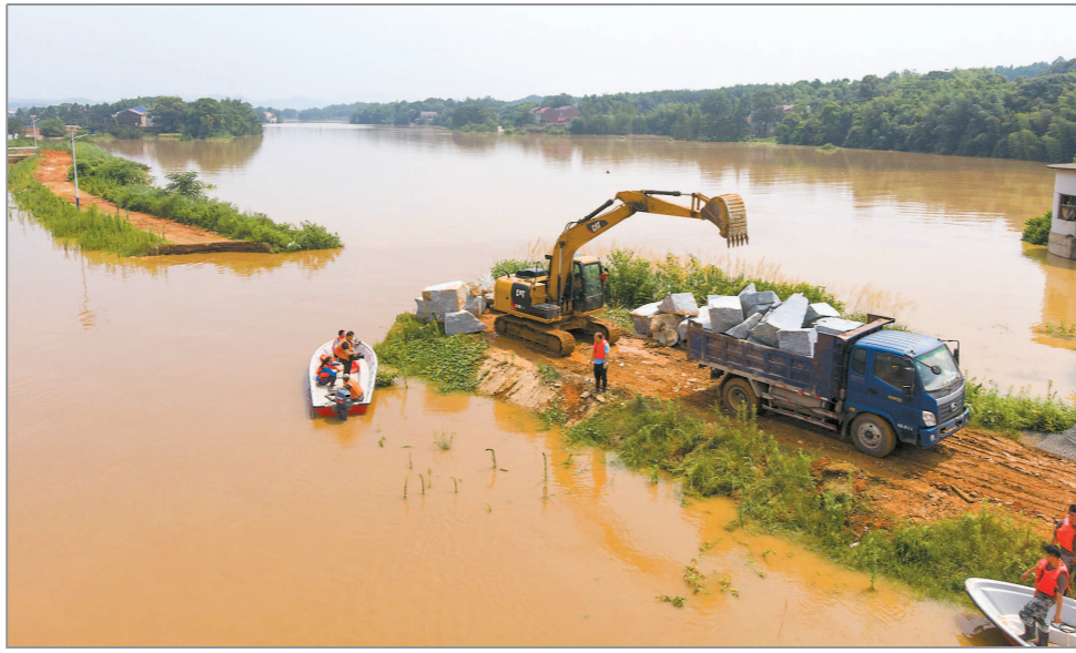
7月10日,湘江大堤湖南衡山县长江镇曹家湖段出现漫堤决口,衡山县水利局及时调来车辆进行抢险作业(无人机拍摄)。新华社发
