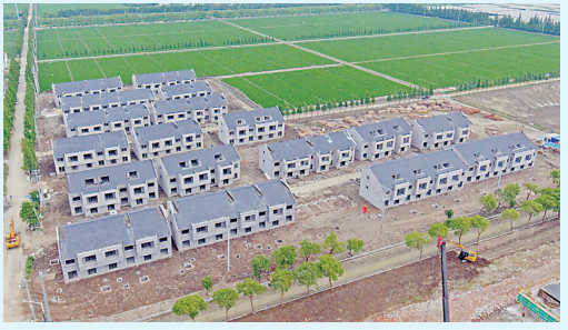
松江黄桥村农民集中居住新房在建设中。蔡斌 摄
