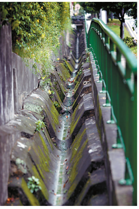
新加坡路边的排水渠 资料图片
