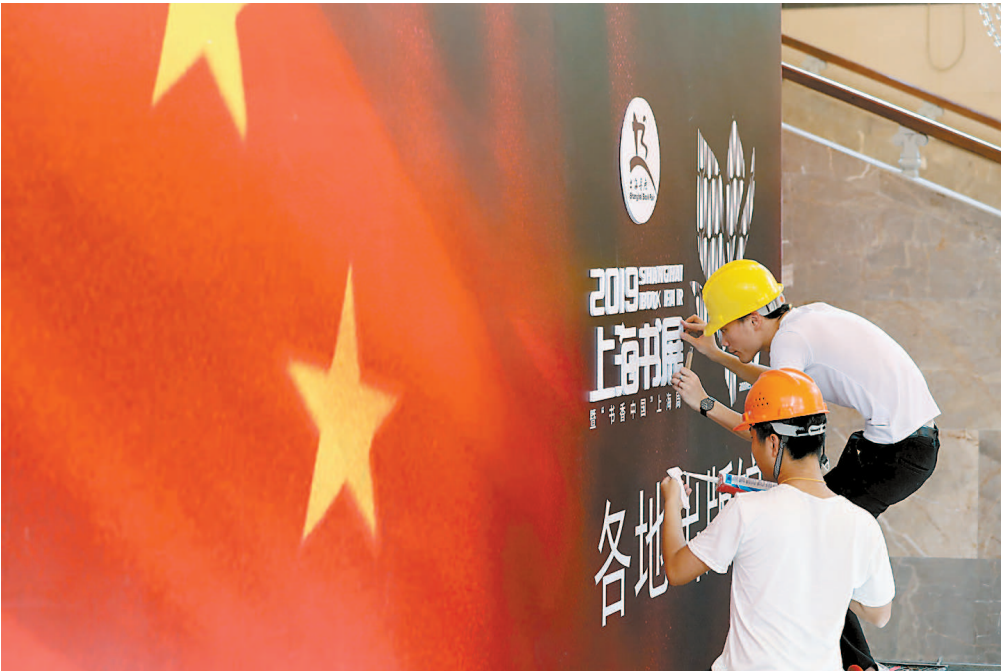
昨天,2019 上海书展布展紧锣密鼓,工人站在脚手架上固定招牌。均 本报记者 蒋迪雯 摄
