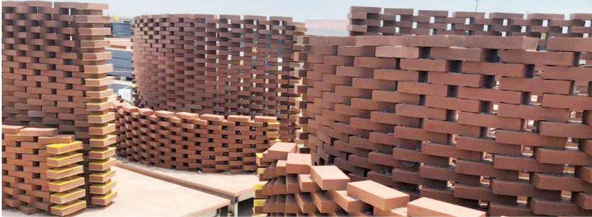
在乌镇工地现场,机器人砌起几道样品墙。
