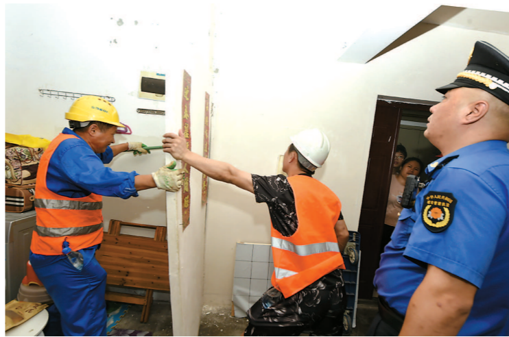
执法人员当场拆除违规隔断房。车佳楠 摄
