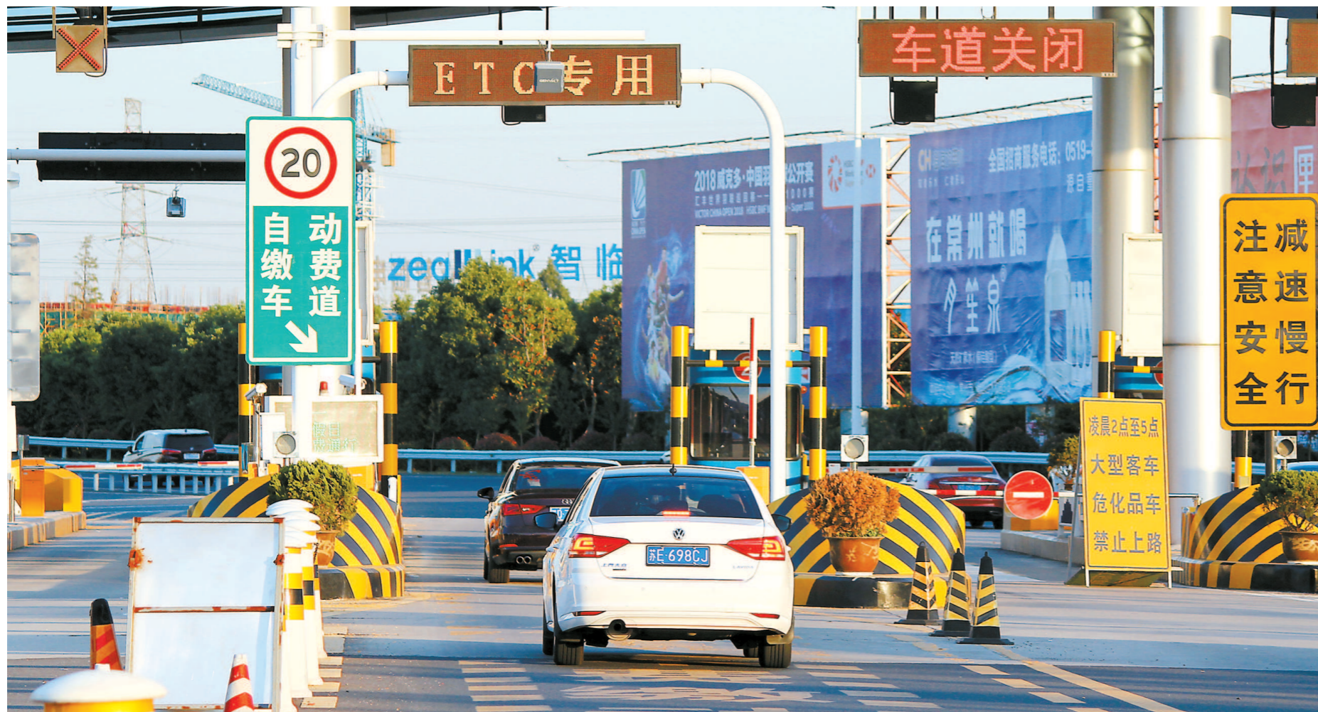
江苏南通一处高速公路收费站的ETC通道。
