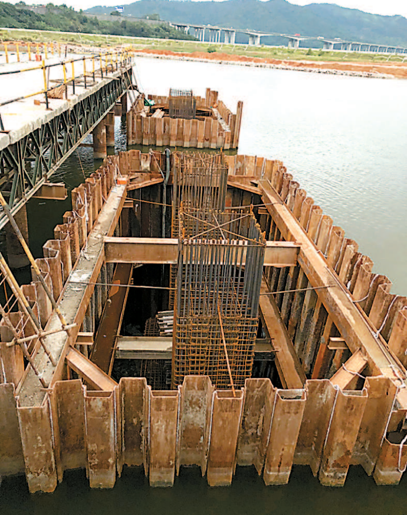
2019年3月13日,水中承台立柱施工。
