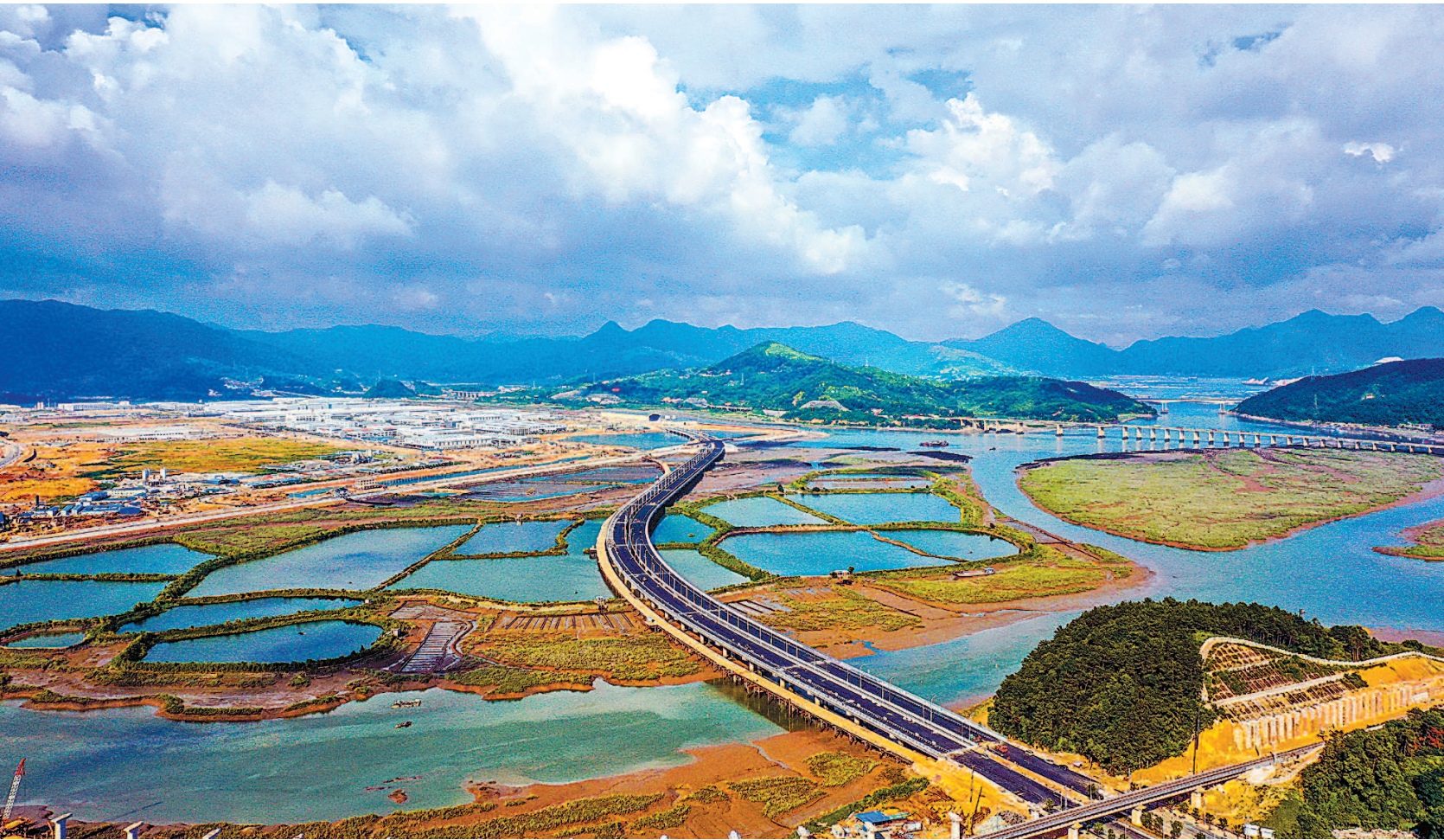
经过15个月建设,全长2561米的七都溪特大桥全面建成。
