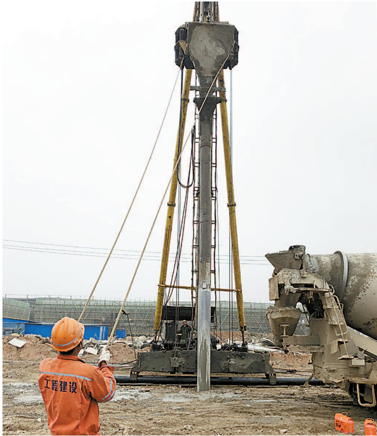
2019年农历大年初一,建设者正进行园区道路软地基处理。
