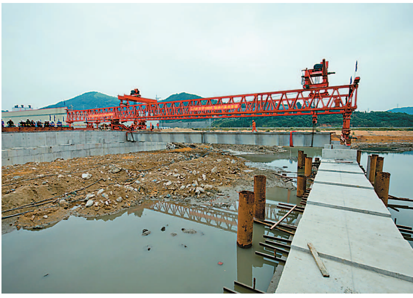
2018年11月15日,架设首幅箱梁。
