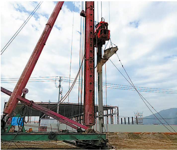
2018年7月18日,路网打下第一根砂桩。
