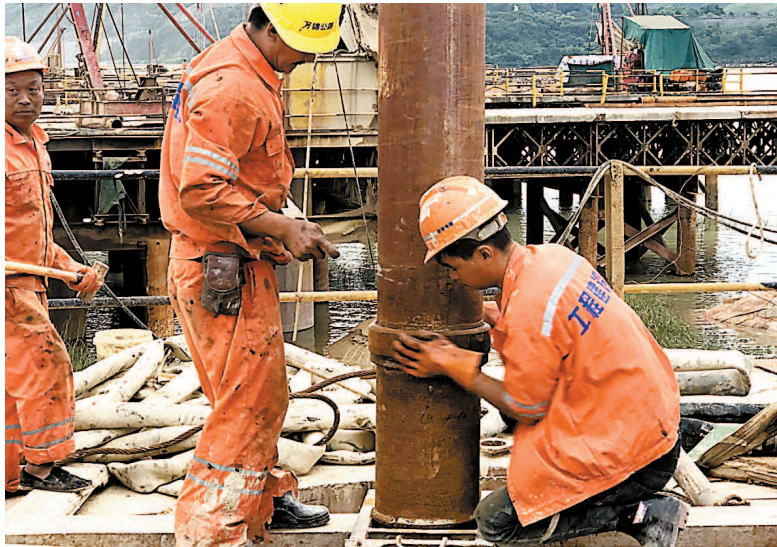
通过选择不同的泥浆比重和冲程,保证桩基承载力。
