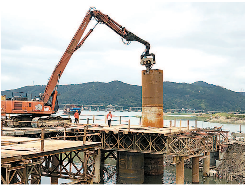
2018年10月1日,埋设钻孔灌注桩钢护筒。
