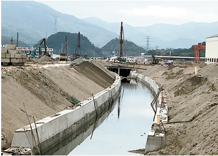
2019年1月25日,园区排水明渠施工。
