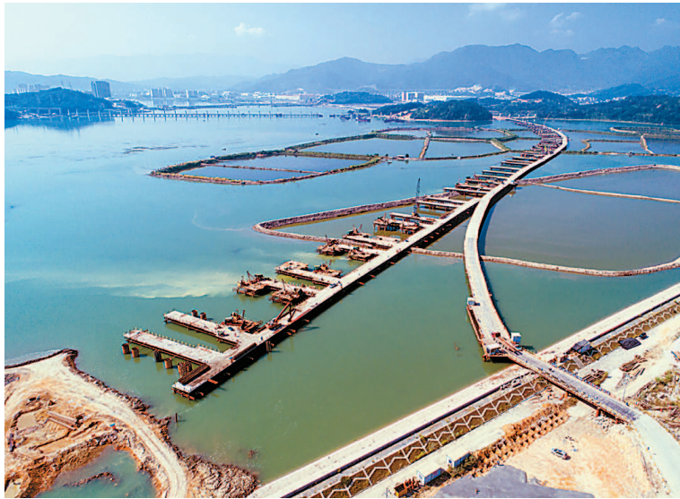
2018年12月30日,桩基施工完成。
