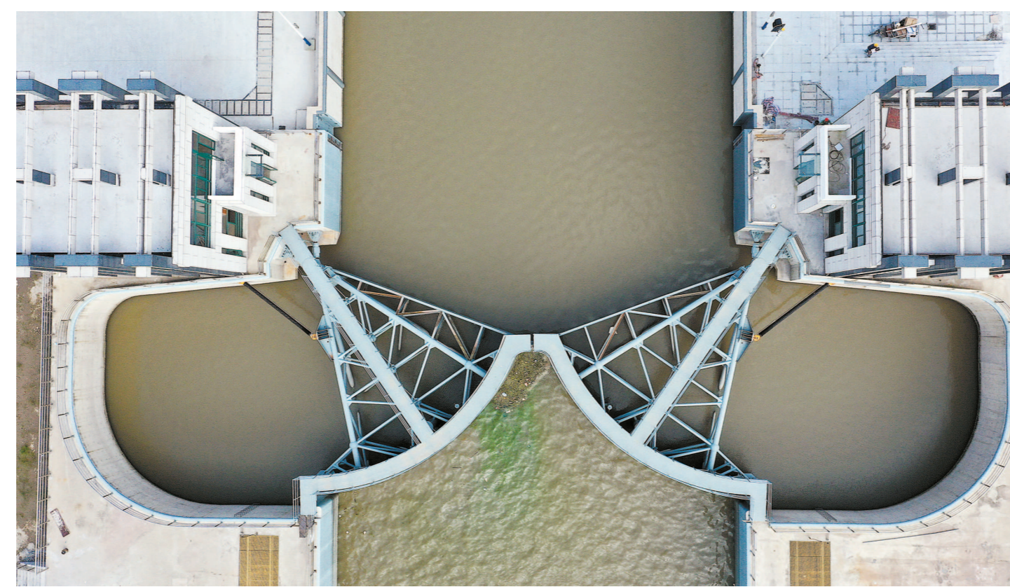
9月9日,上海市大治河西枢纽新建二线船闸主体结构全部建成。未来,苏浙一带的集装箱船从黄浦江过大治河新建船闸,经大芦线抵达芦潮港内河集装箱港区后,中转至洋山深水港,将被运往世界各地。
