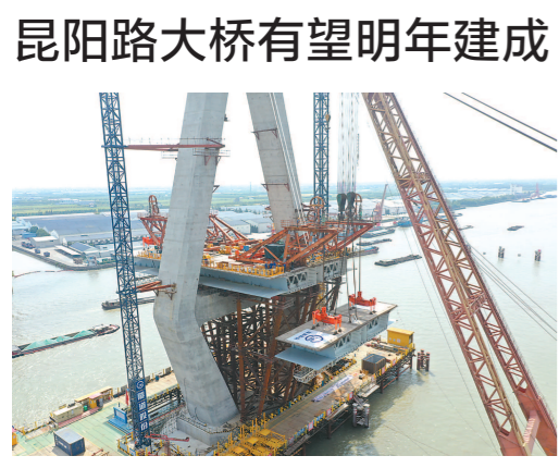
前天,大桥开始吊装主梁。本报记者 张海峰 摄
