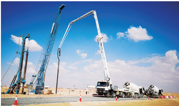
迪拜 950MW 光热光伏项目施工现场
