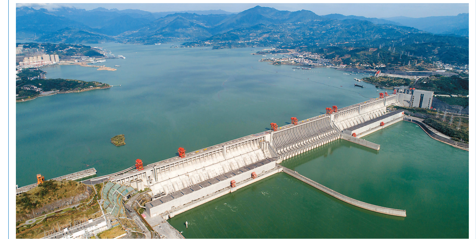
最后冲刺 10月28日在宜昌市秭归县拍摄的三峡大坝(无人机拍摄)。截至28日20时,长江水文网实时水情显示,三峡水库水位已达到174.43米,三峡水库2019年175米试验性蓄水进入最后冲刺阶段。 新华社发
