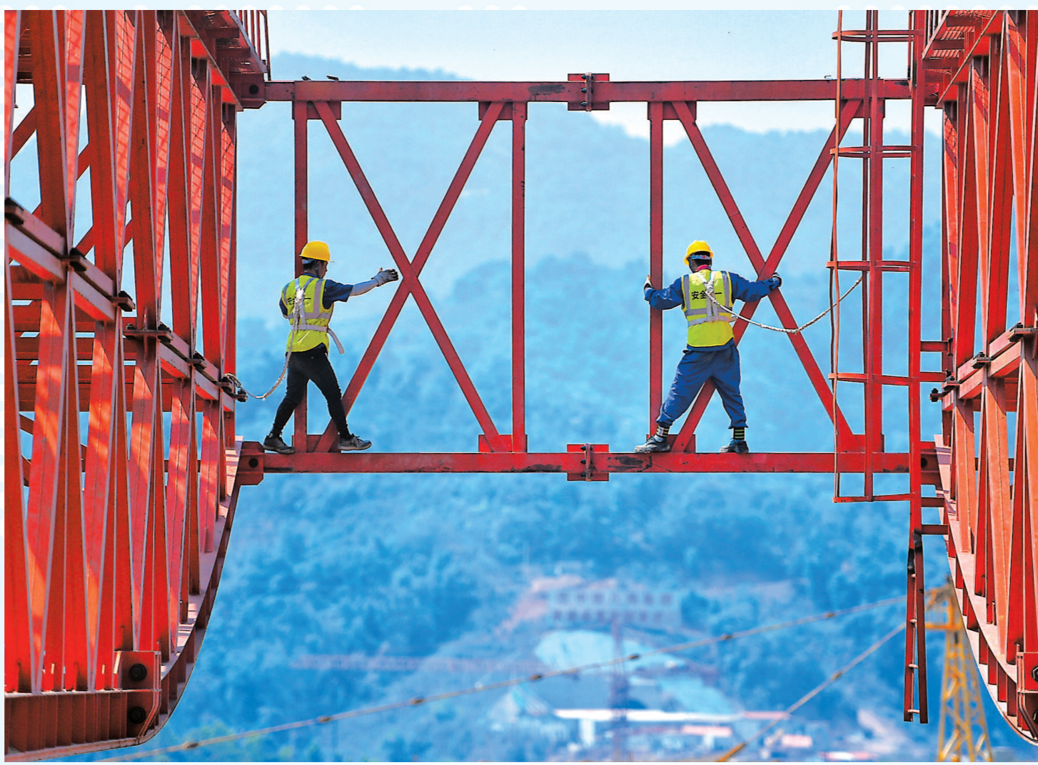
在木乃河双线特大桥工程现场,工人正在进行架桥机前横联螺栓检查及二次紧固,大桥是中老铁路国内段的组成部分。中国参与的基建设施出现在全球各地,很多国家活跃着中国装备、中国建造、中国技术的身影……来自中国的基建队伍联通了世界,也为构建“人类命运共同体”贡献着力量。 新华社发
