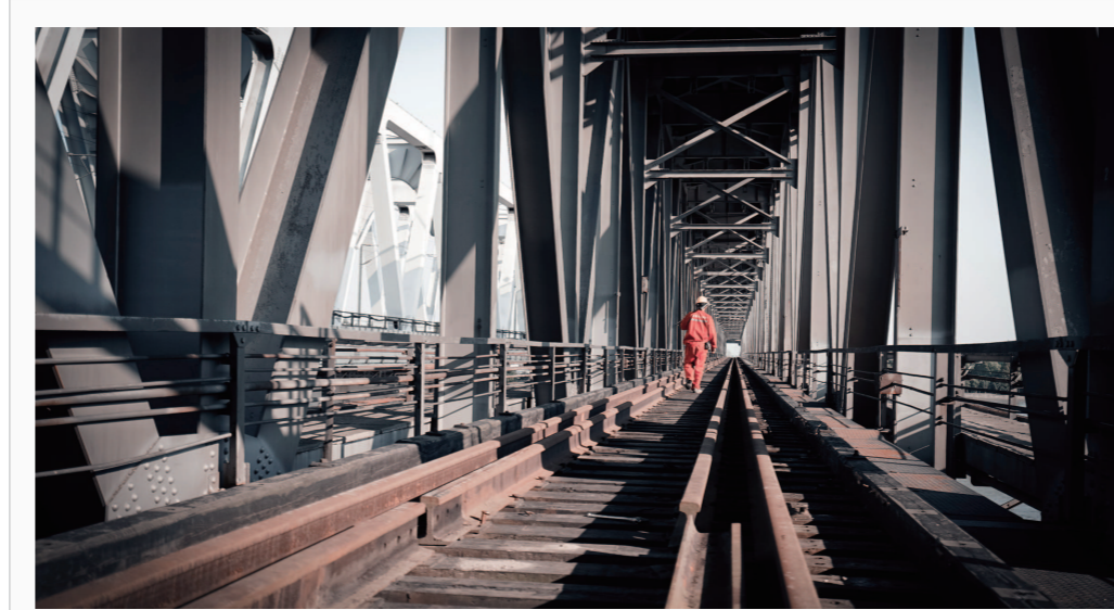
市政总院松浦大桥大修工程
