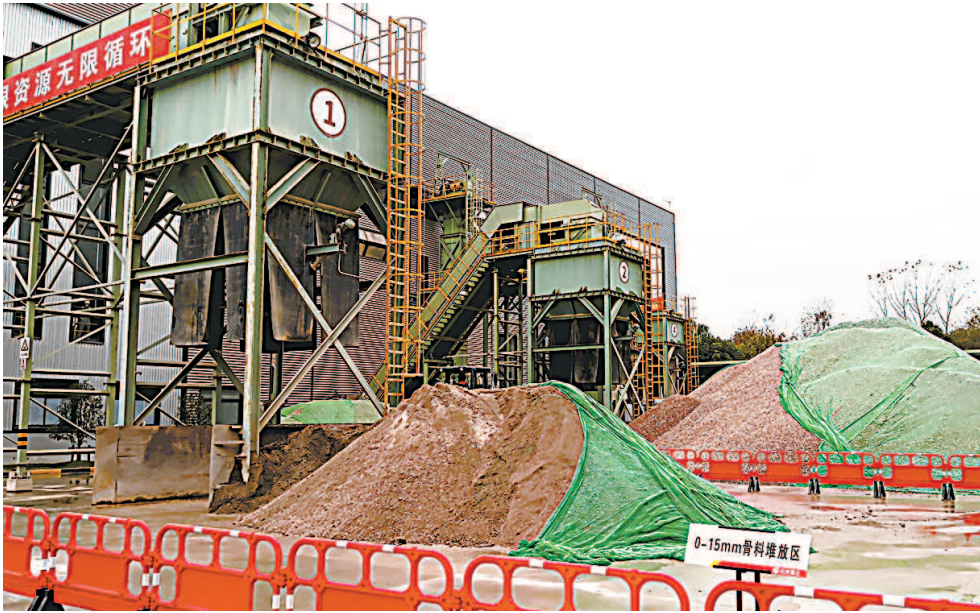
宝山装修垃圾资源化处置项目投入试运营。
