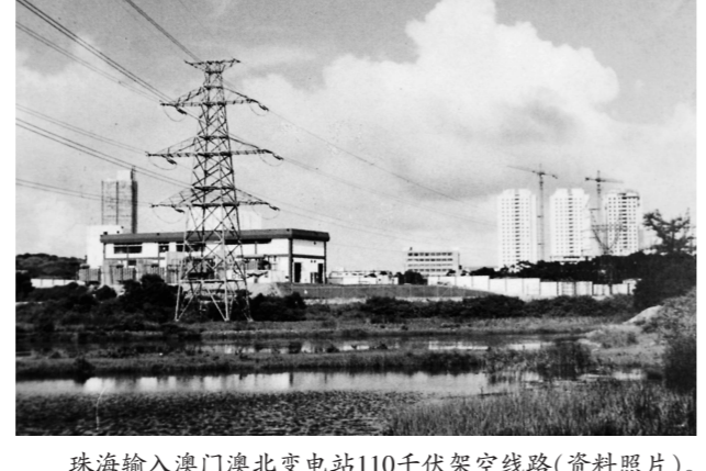
珠海输入澳门澳北变电站110千伏架空线路(资料照片)。
