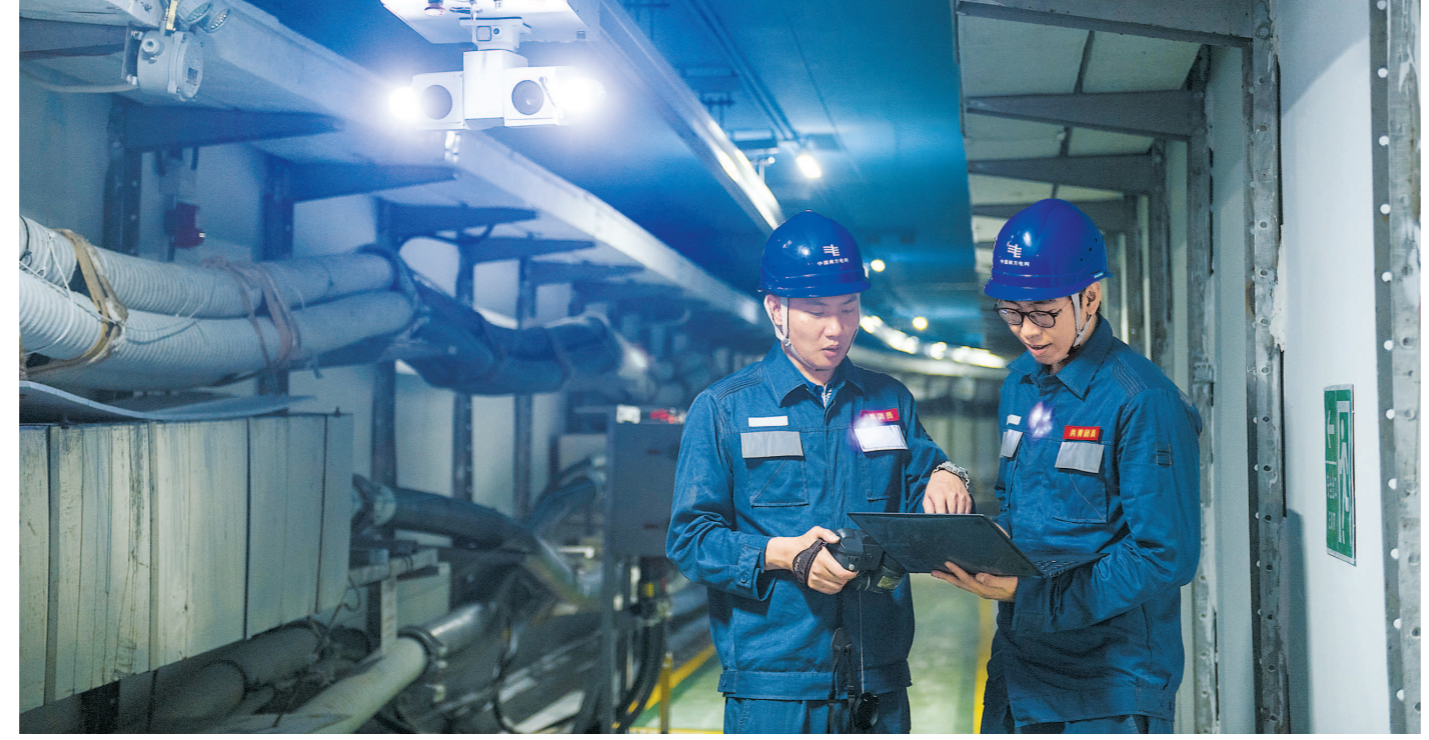
南方电网广东珠海供电局输电管理所工作人员对环琴甲乙线地下管廊进行巡查,确保珠澳电网安全稳定(4月11日摄)。均新华社发
