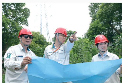
工程先锋队现场踏勘
