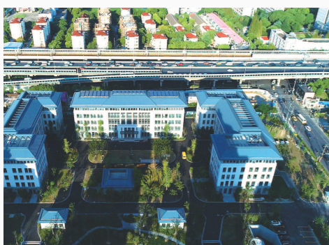
500千伏虹杨变电站工程
