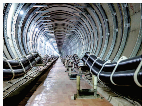
500千伏虹杨电力隧道
