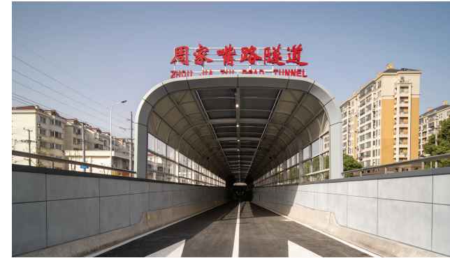
周家嘴路隧道
