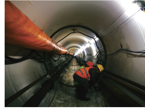
广东珠海平岗—广昌原水供应保障第二标段(过磨刀门顶管段)
