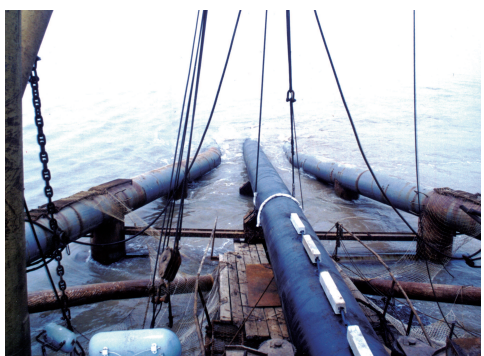
浙江舟山大陆引水一期跨海段钢管敷埋
