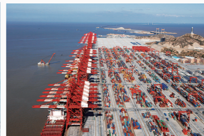
上海洋山深水港区工程
