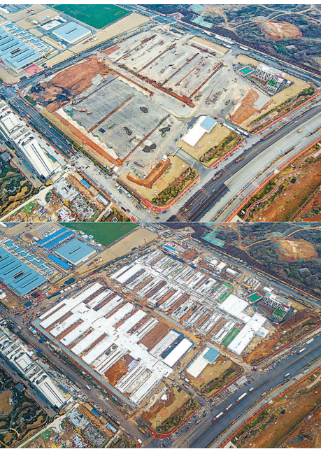
这是一张武汉雷神山医院建设工地的拼版照片;上图摄于1月27日(无人机照片);下图摄于2月7日(无人机照片)。 新华社发
