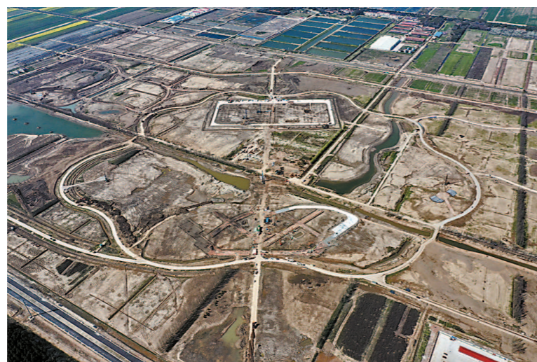
花博园施工现场
