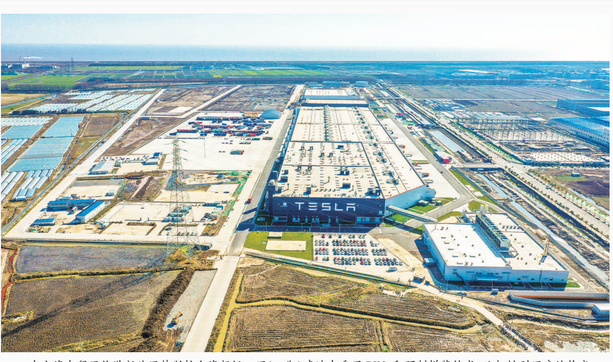
在上海自贸区临港新片区特斯拉上海超级工厂(一期)建造中采用BIM和预制拼装技术,从打桩到厂房结构完工仅用了6个月,充分展现了“上海速度”。
