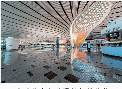
参建北京大兴国际机场装饰工程,通过三维激光扫描、三维深化设计、数字化加工与测量安装技术,仅用3个月便呈现出“如意祥云”的极致效果。
