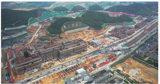
承建中山大学深圳校区、深圳大学西丽校区、深圳技术大学等高校项目,助力粤港澳大湾区建设具有世界一流水平的大学校区。
