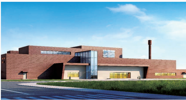
在甘肃武威参与第四代先进核能系统钍基熔盐实验堆工程建设,打造洁净高效的复合能源系统,为我国钍资源高效利用与核能综合利用积极贡献力量。
