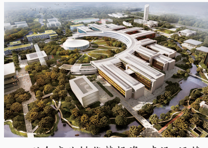
以全产业链优势投资、建设、运维杭州西湖大学建设工程,运用BIM、物联网、人工智能等全数字化建造技术做好项目的全生命周期服务,不负建设世界一流大学的时代使命。
