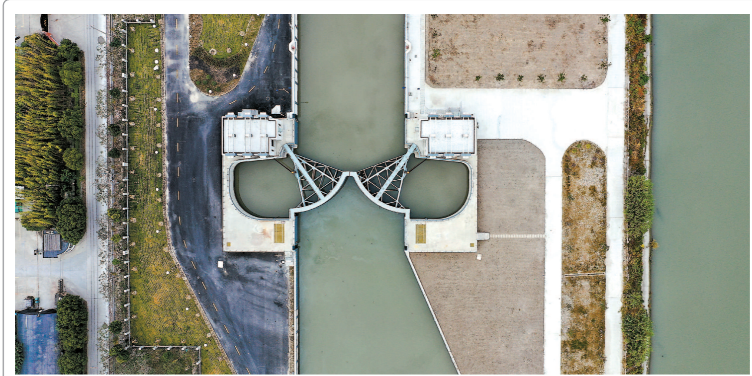
即将投入运行的大治河西枢纽二线船闸。
