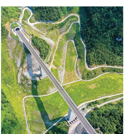
7月6日拍摄的安六铁路彭家冲一号大桥(无人机照片)。
