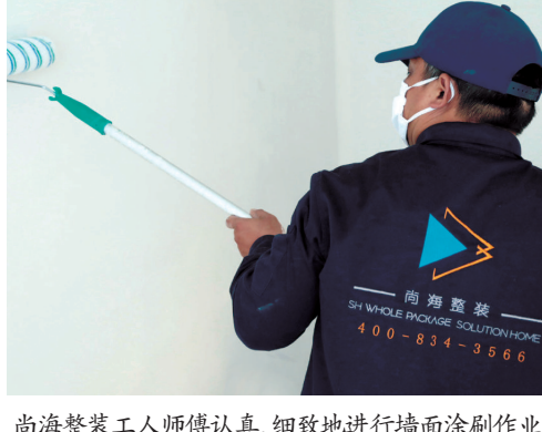
尚海整装工人师傅认真、细致地进行墙面涂刷作业。
