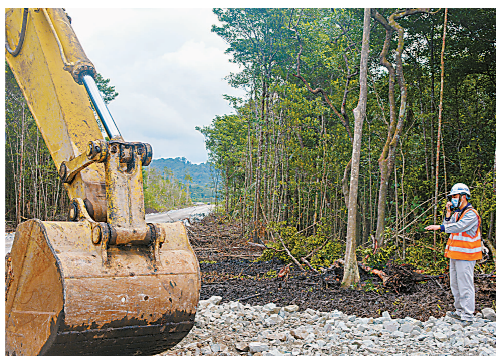
9月30日,在马来西亚丁加奴州北加镇,一名技术员在中国交通建设集团有限公司承建的马来西亚东海岸铁路(东铁)项目施工现场工作。新华社发
