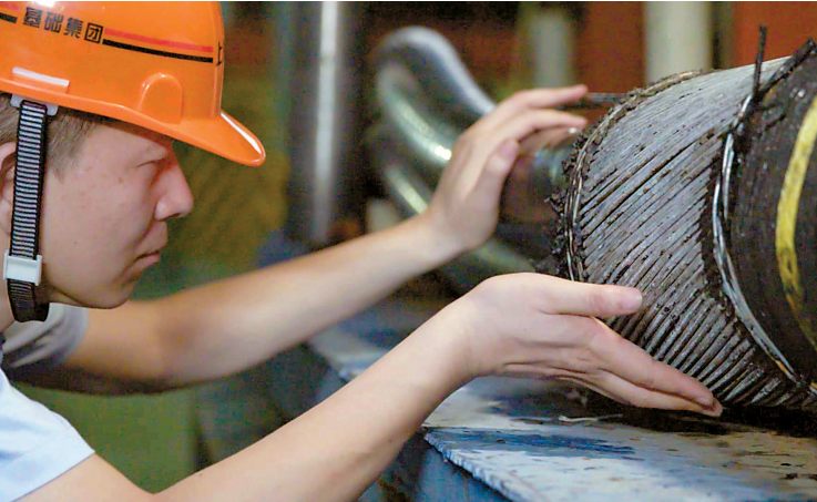
沈光指挥铺设海底电缆。
