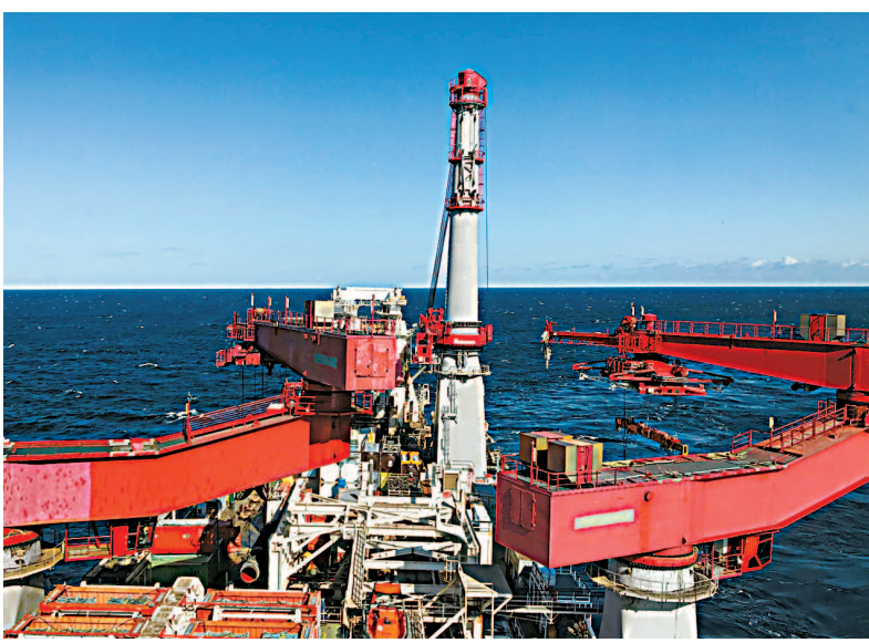
在波罗的海,工程船正在铺设“北溪—2”天然气管道。新华社发(资料照片)
