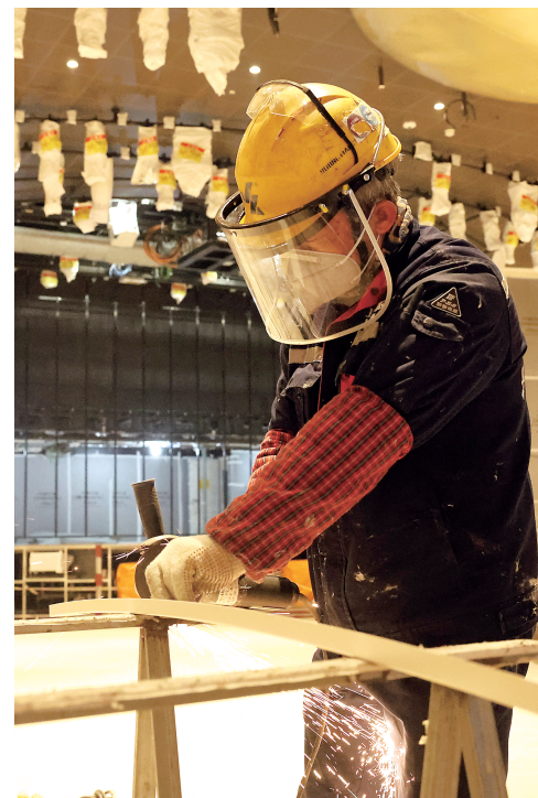
工人在切割空调出风口部件。
