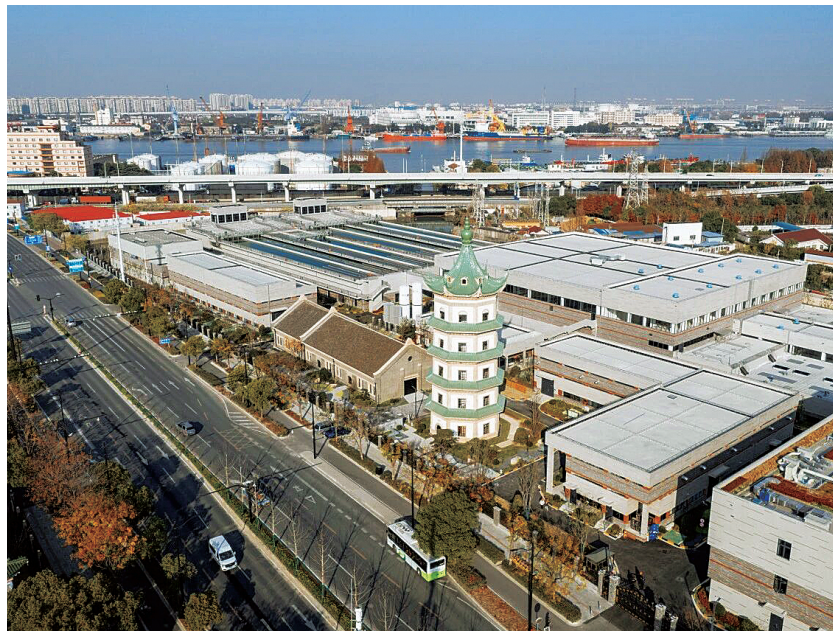
修缮后的闸北水厂 图源：公众号“历史建筑保护设计院”
