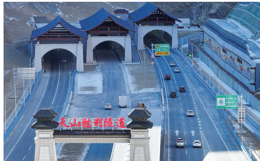
车辆行驶在新疆乌尉高速公路天山胜利隧道入口端附近。
