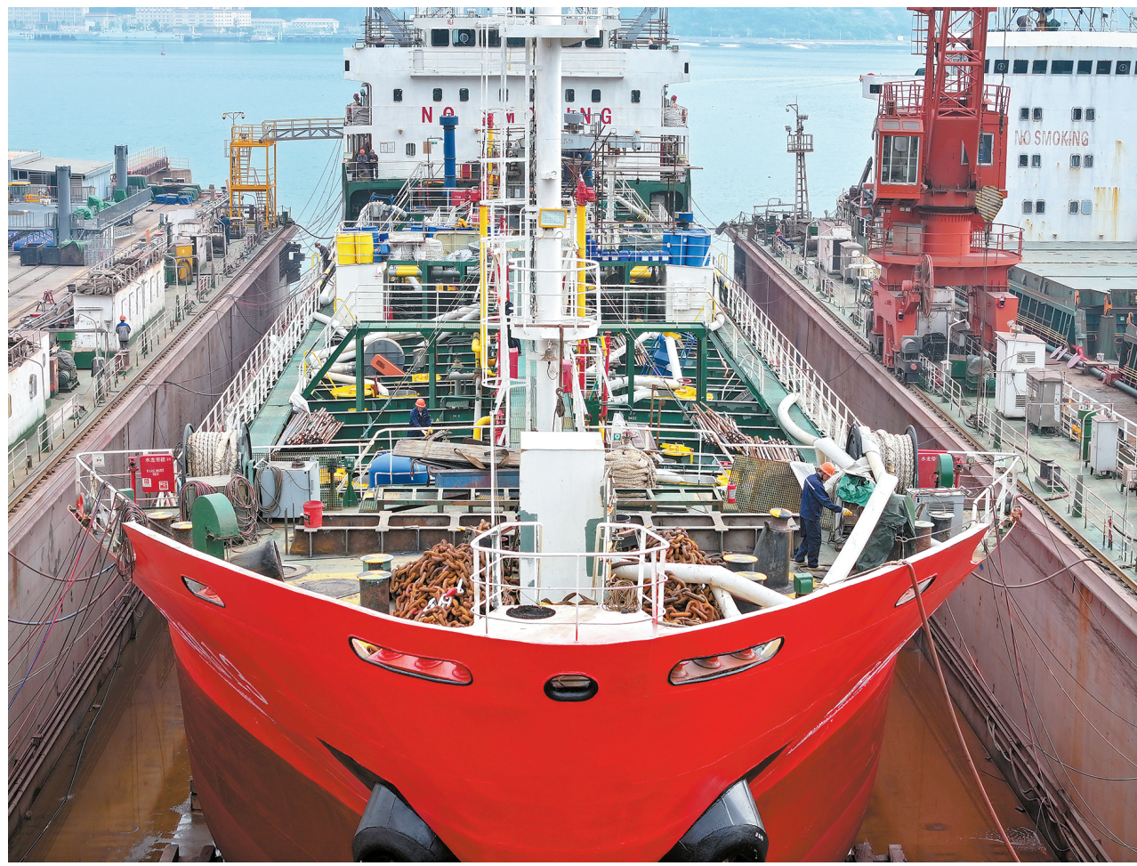
4月27日,在江苏省连云港鸿云实业有限公司生产基地,一艘船舶正在建设中。
