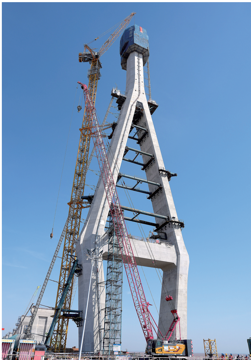
杭州湾跨海铁路大桥南航道桥首座主塔封顶
