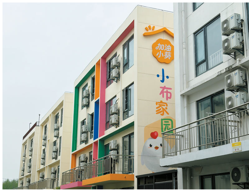
今年3月,位于闵行区疏影路的“小布家园”7号楼启用。
