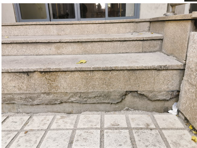
▲ 4号楼无障碍坡道路面碎裂 ▲ 4号楼门厅外台阶与地面脱开
